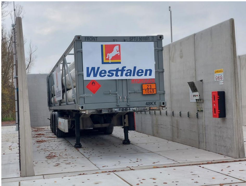
Figuur 1: Trailerwissel (los)plaats (Lochem) verbonden met lokaal gasnet
