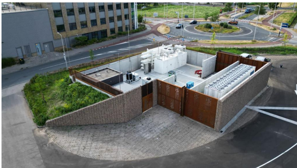
Figuur 4: Bovenaanzicht waterstoftankstation Amersfoort met trailerlosplaats (Fountain Fuel)
