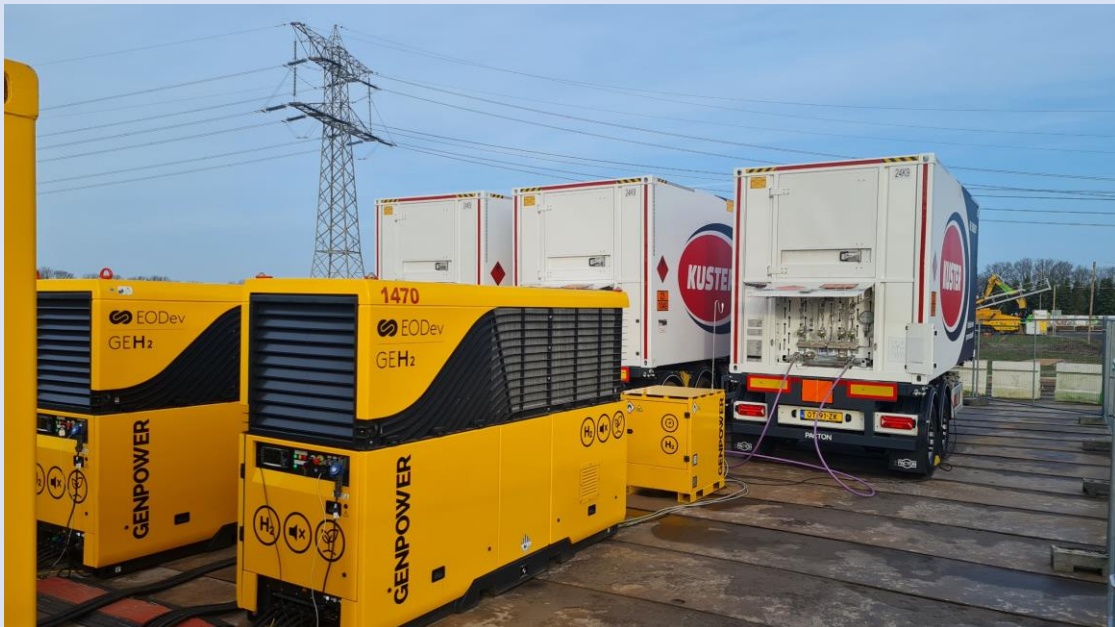
Figuur 5.1 Voorbeeld toepassing waterstofaggregaat bouwplaats. Foto: Paul Bombeld.
