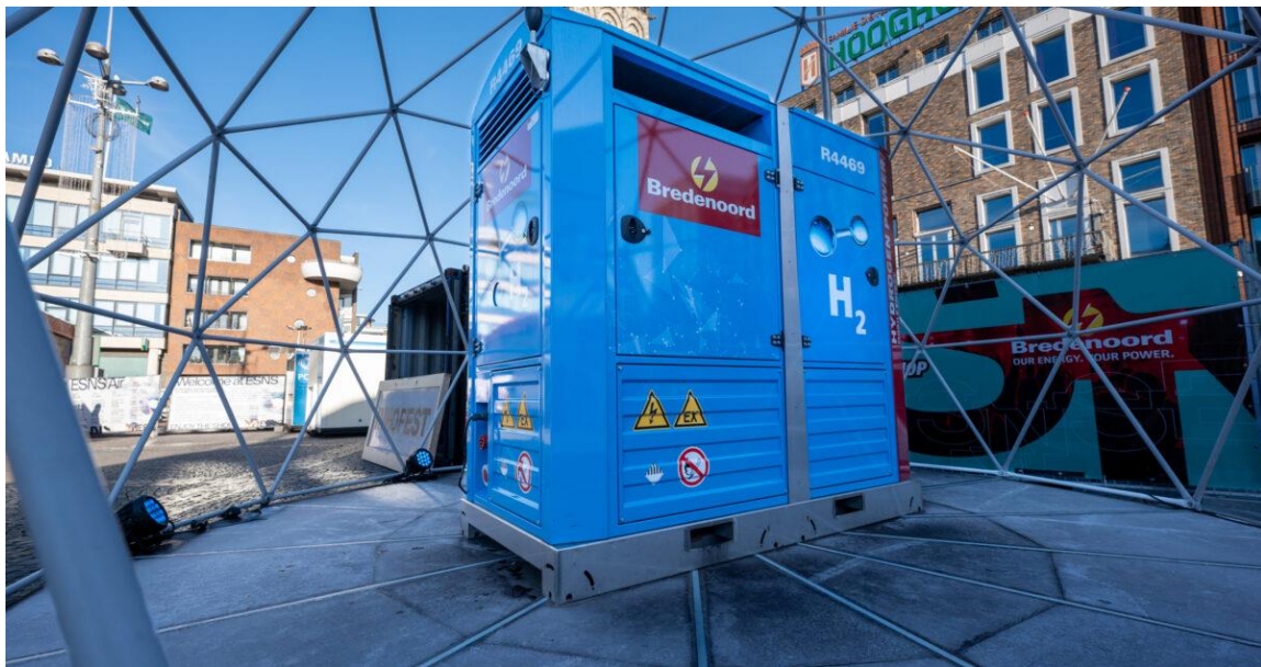
Figuur 5.2 Voorbeeld toepassing waterstofaggregaat Eurosonic, Groningen. Foto: Bredenoord .
